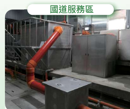
新東陽各據點廢污水管理行動成效
